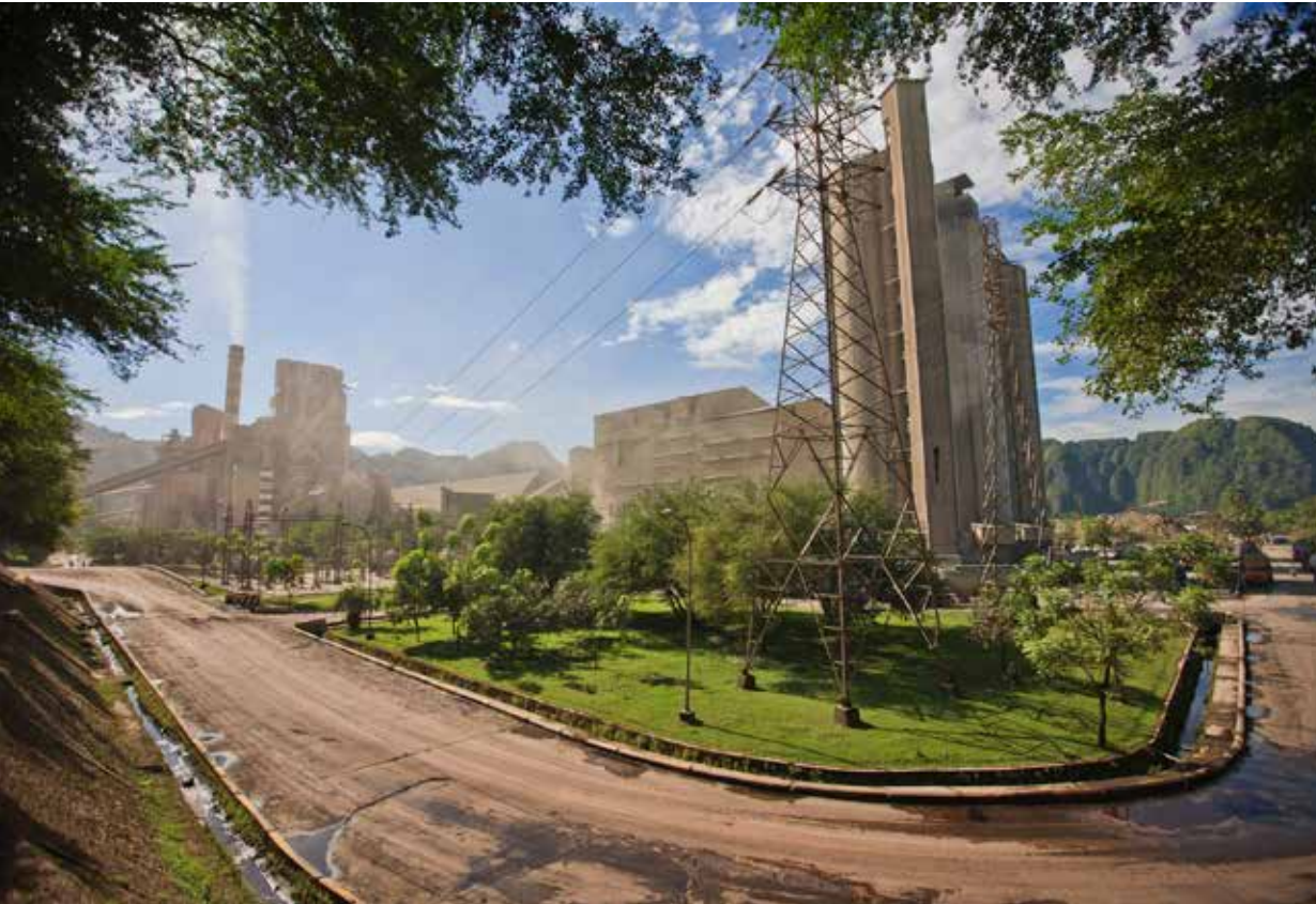
Lingkungan sekitar Boiler Turbin Generator Unit 1
