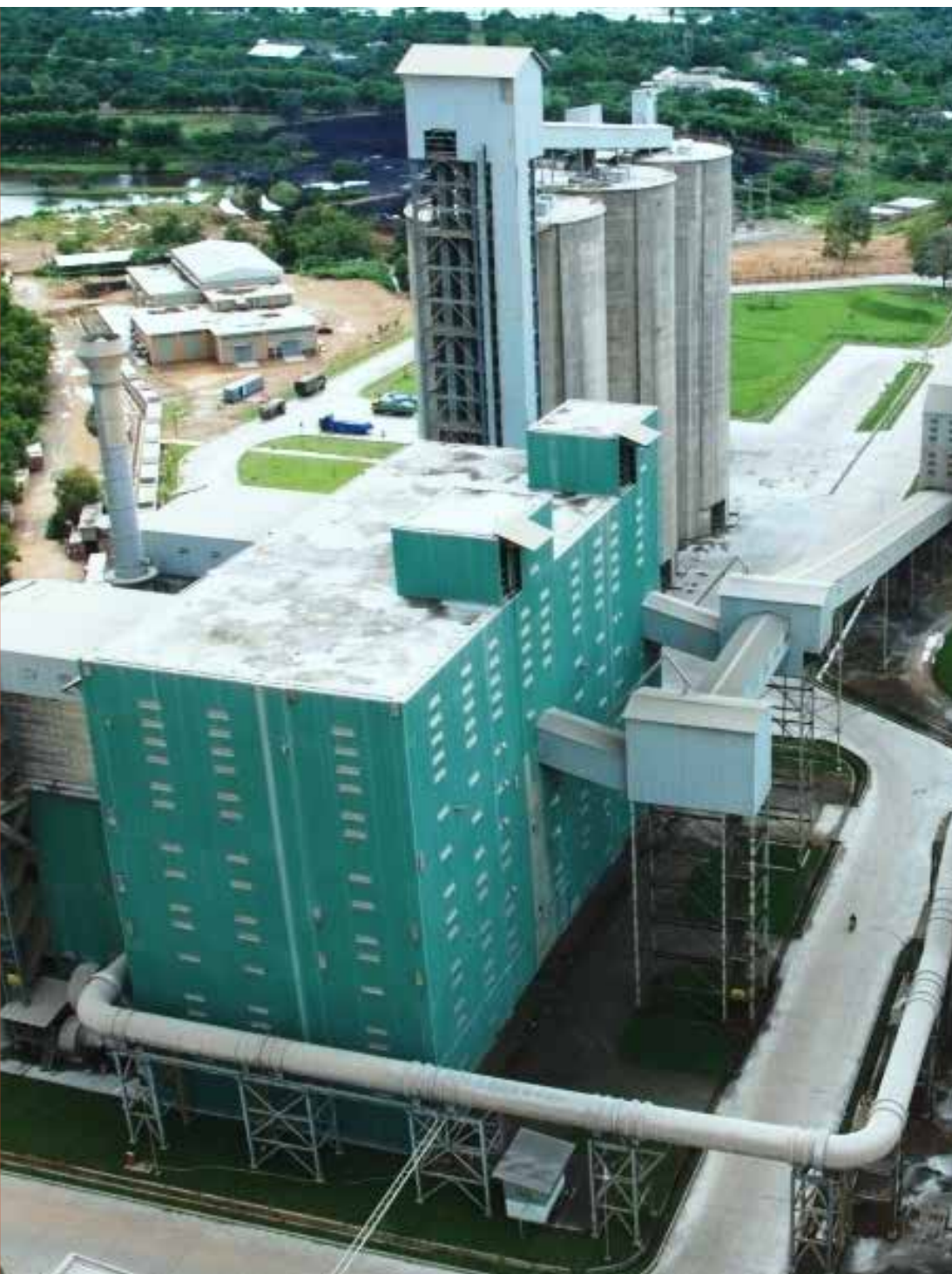
Pabrik Tonasa unit V
