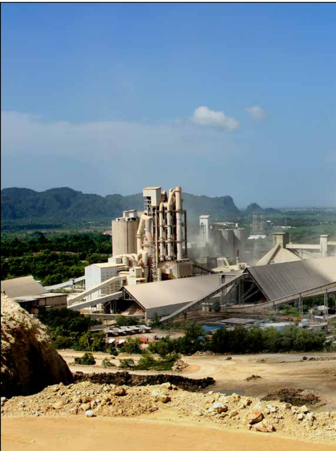
Pabrik Tonasa Unit V
