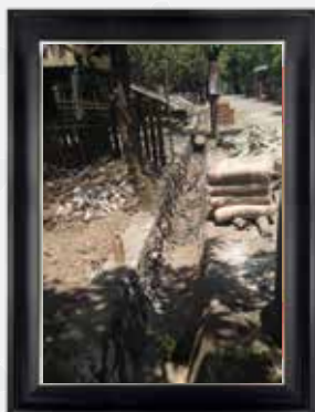
Agustus August Pembuatan Drainase 2. Drainage Construction 2.
